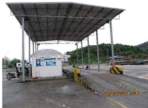
ภาพถ่ายที่ 2.2-7 เครื่องชั่งน้ำหนักรถบรรทุก
